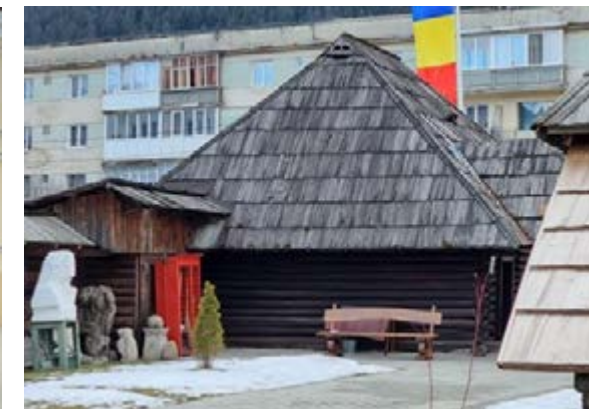
Foto 4. Fațada de nord a casei și șopronul destinat materialelor PSI
