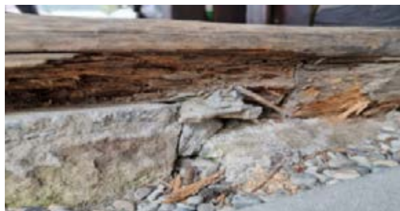
Foto 25. Lemn fragilizat datorită atacului biologic, la-cune provocate de șocuri mecanice
