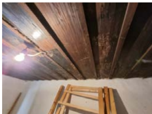
Foto 27. Tavan camera marescânduri defor-mate, modificări cromatice
