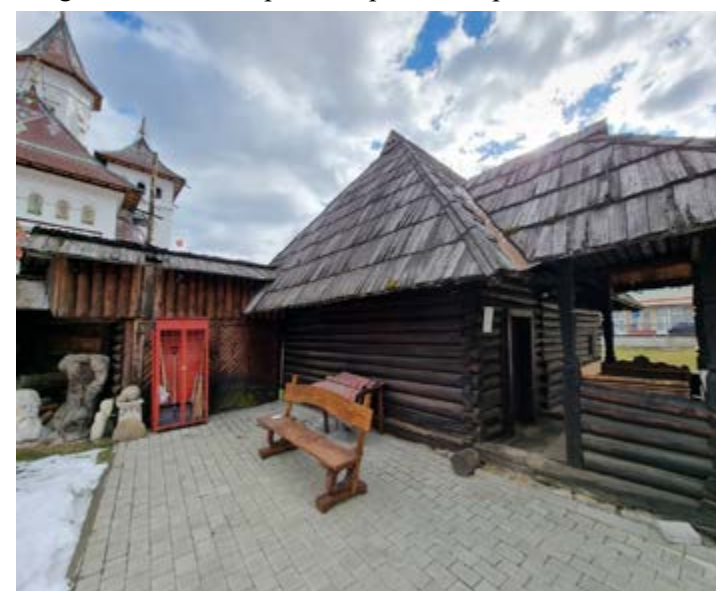
Foto 10. Colț nord-vest și îmbinarea (pereți și acoperiș)
