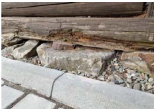
Foto 26. Lemn fragilizat datorită atacului biologic
