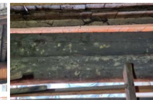
Foto 23. Murdărie aderentă, atac active al insectelor xilofage, urme atac fungic, pete de umiditate
