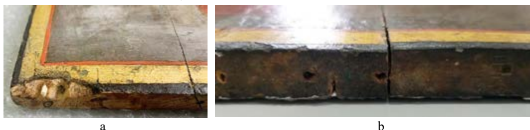
Fig. 7. Cantul superior: lipsă suport de lemn (a), dezlipirea și distanțarea panourilor la îmbinări (b)
