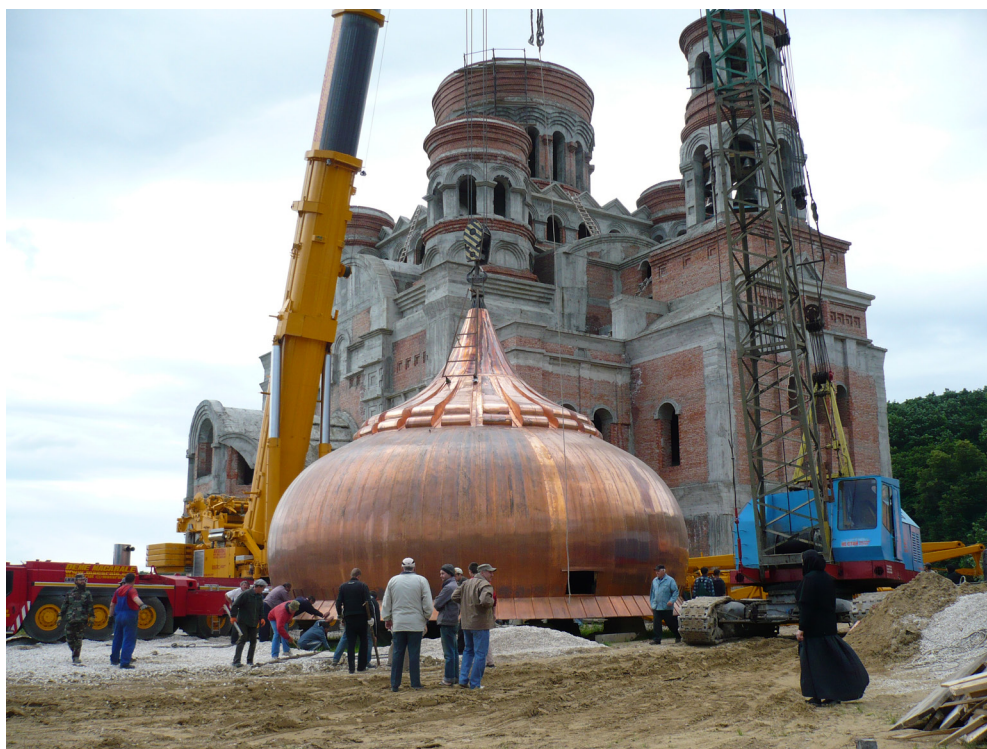
Fig. 55. Biserica de vară a mănăstirii Hâncu în construcție (arhitect S. Homa) (foto S. Homa)
