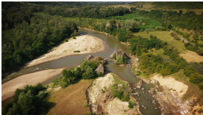
Blocurile de calcar de la Bădila – vedere generală
